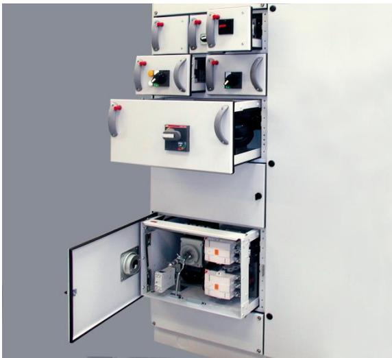
Las puertas de los cubículos (sean fijos, amovibles o extraíbles) son accesibles (sólo por personal de mantenimiento) facilitando la realización de termografías y el ajuste de las protecciones
