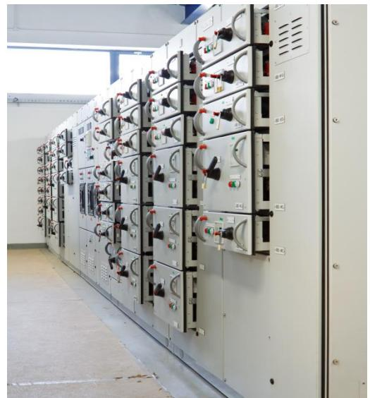
Los distintos tipos de módulos (fijos, amovibles y extraíbles) se combinan para lograr soluciones eficientes técnica y económicamente
